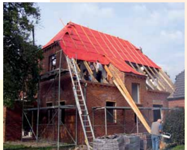
Bauarbeiten am Pfarrhaus
